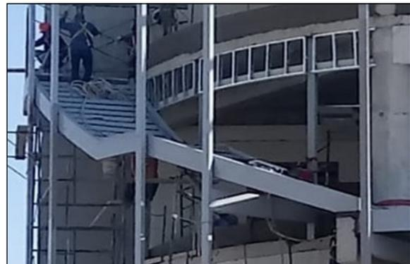
**Figura 24.** Escalera helicoidal fabricado e instalado.
