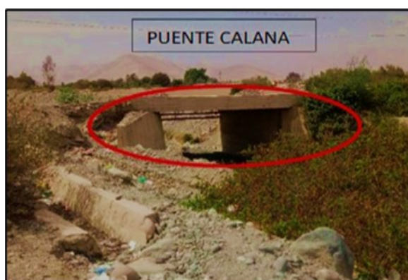
Figura 4. Vista frontal del puente Calana, material del presente caso aplicativo.
