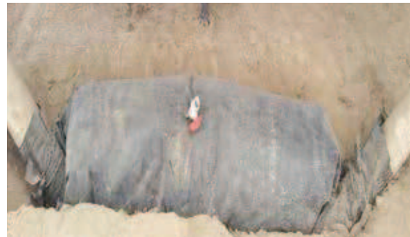
Figura 1. Biodigestor de plástico de color negro (polietileno de alta densidad)
